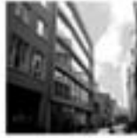
Holzgraben 5, Frankfurt. Neubau
